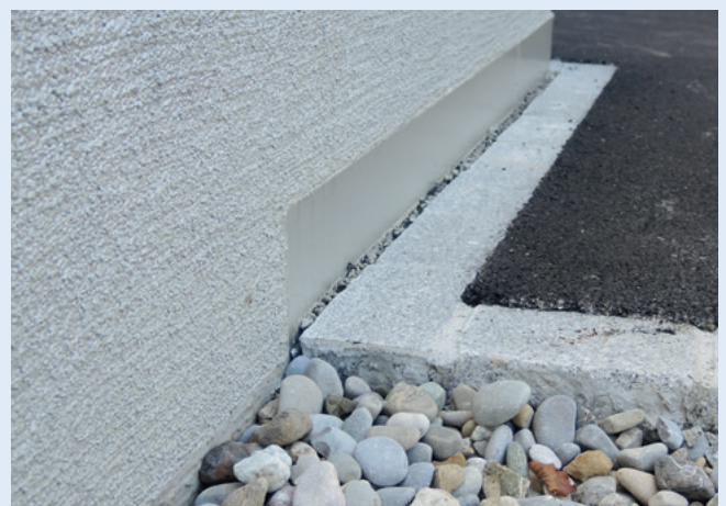
Bild oben: Bundstein in Beton versetzt, Asphaltbelag.
