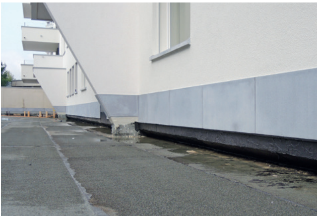
Abb. 3 Spritzwasserschutz durch Sockelelemente.
