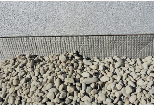
Abb. 6 Druckfeste Drainagematte als mechanischer Schutz der Fassade (Vlieslage aussen) während der Auffüllarbeiten mit Rundkies.
