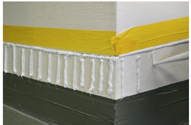
Abb. 11 Vertikales Auftragen von Klebstoff zur Montage des Sockelschutzbleches.
