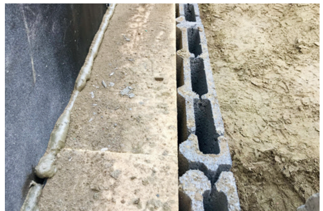
Abb. 1 Filter-Sickerplatte vor Perimeterdämmung.
